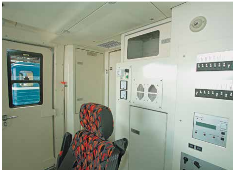
Аппаратный отсек со вспомогательным пультом и панелями вагонной и поездной защиты
